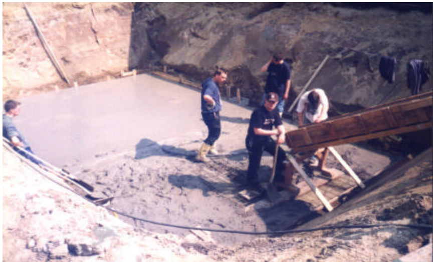
Herstellen der Betonsohle durch Schüler
