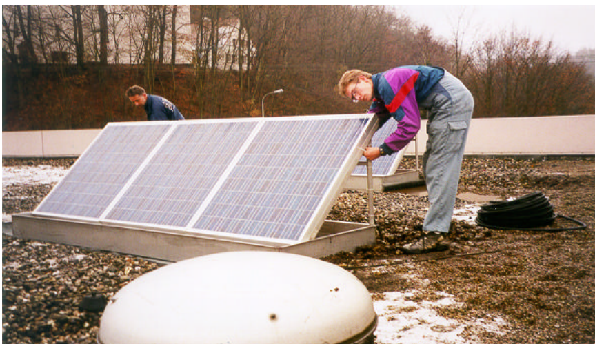
Installation einer Photovoltaik-Anlage auf dem Flachdach der Franz-von-Sickingen-Schule in Wallhalben
