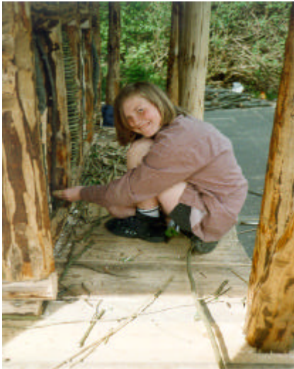
Die Ruten werden in die Staken geflochten
