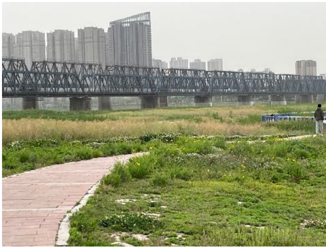
Deutsche Eisenbahnbrücke von 1911
